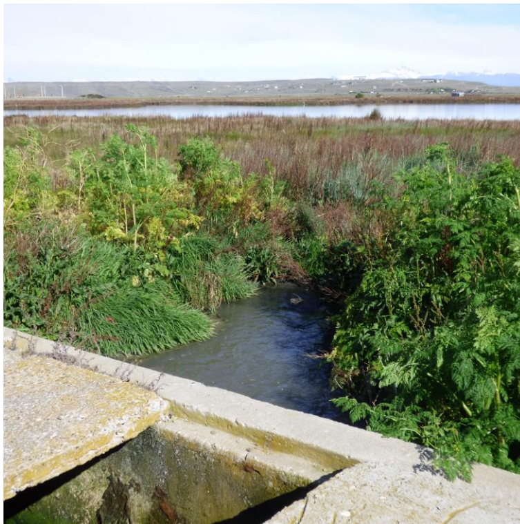
Fotografía 3: Cisterna de ingreso del agua tratada a la laguna Nimez (Estación 2).
